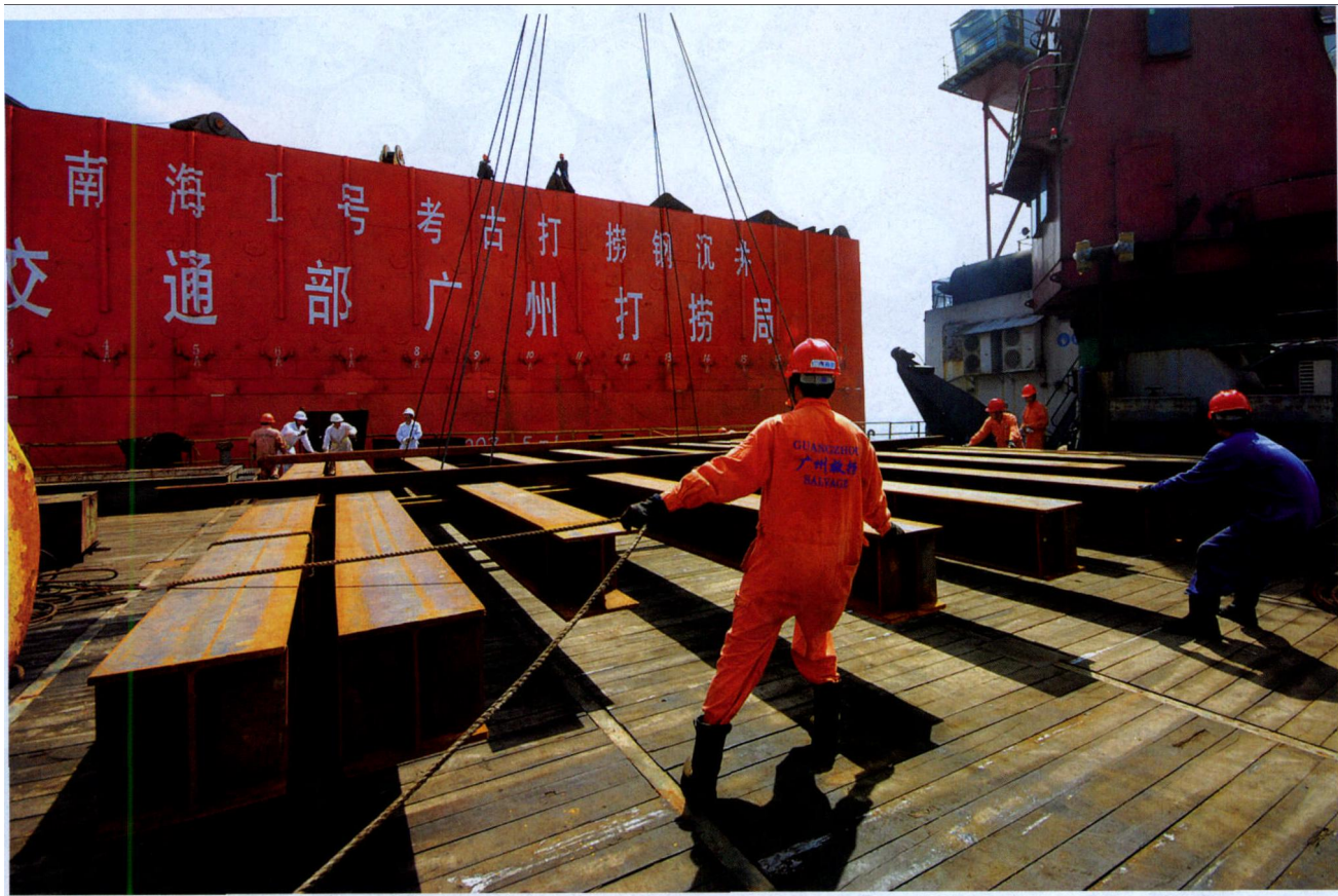
(上图)“南海一号”打捞是我国南海水下考古的第一个“大手笔”，2007年底这艘全长达30余米的南宋沉船被整体打捞出水。“南海一号”发现于1987年，因技术、资金等原因一直沉睡海底，其间船上文物不断被盗。图为打捞人员将沉箱放入海中。
